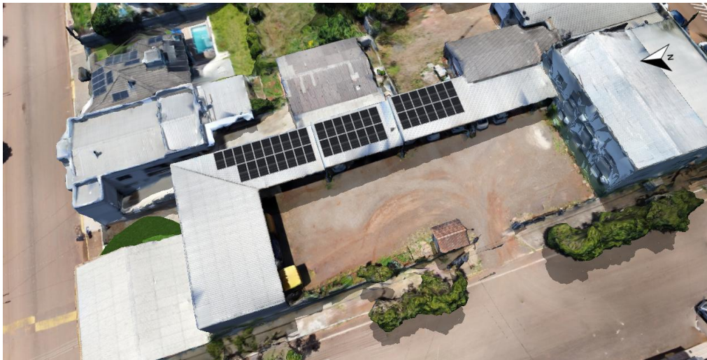
Figura 2 – Distribuição dos módulos no telhado.
