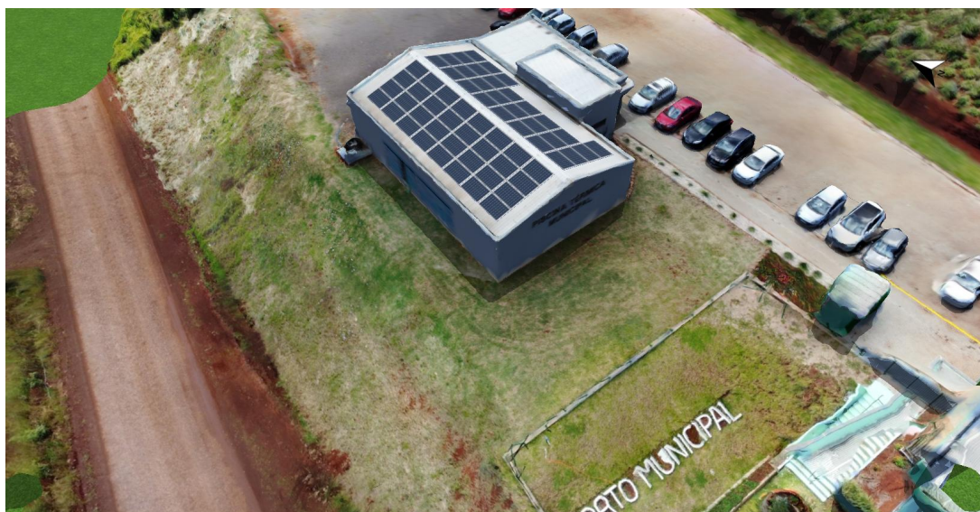
Figura 2 – Distribuição dos módulos no telhado. (129,5 m 2 )
